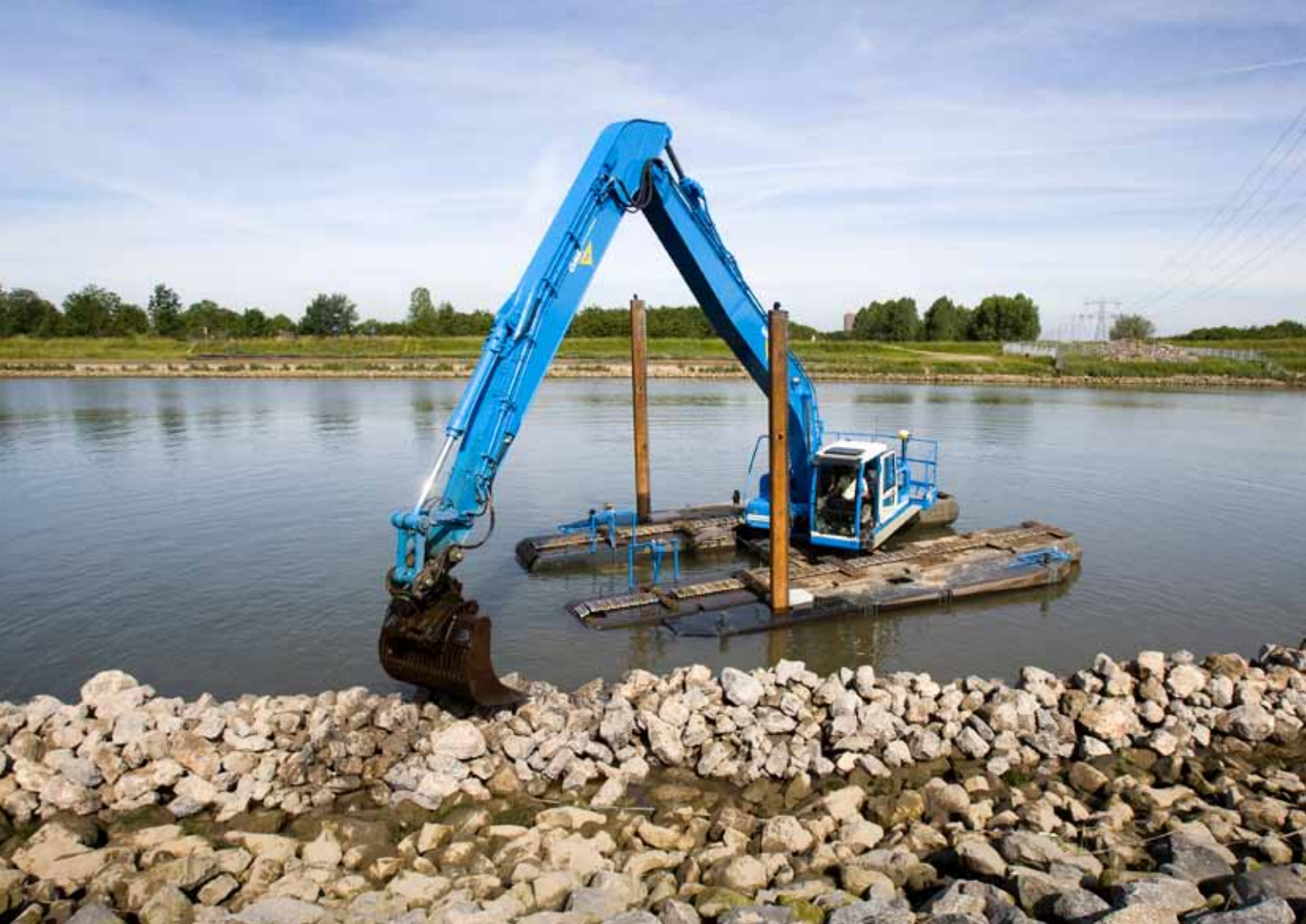
Werkzaamheden aan de Hollandsche IJssel.
