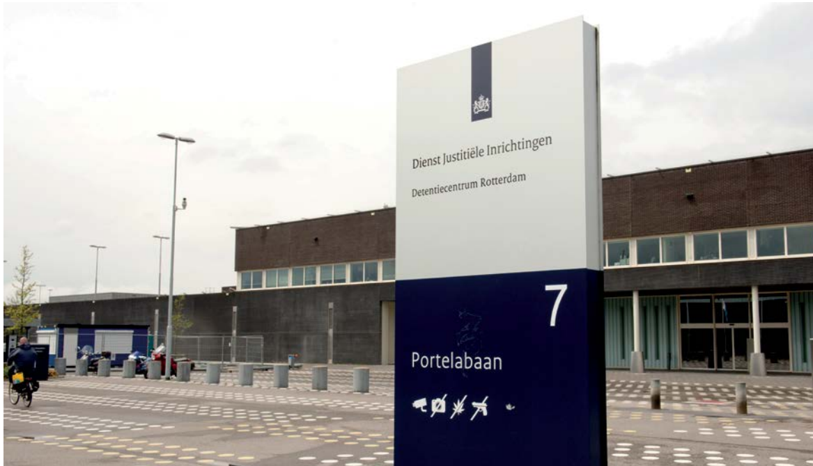
Detentiecentrum in Rotterdam. (Bron: ANP Photo – Marcel Antonisse)
