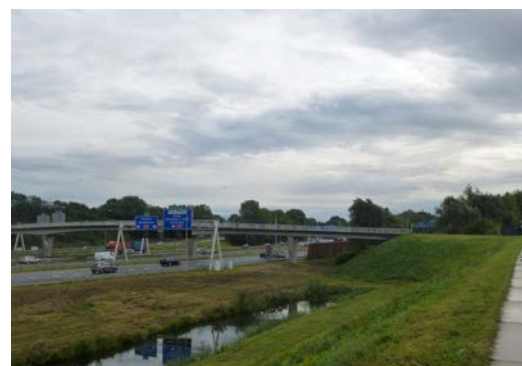
↑ De bestaande fietsbrug over de A12 verbindt Park de Koppel met de recreatieplas Laagraven.
