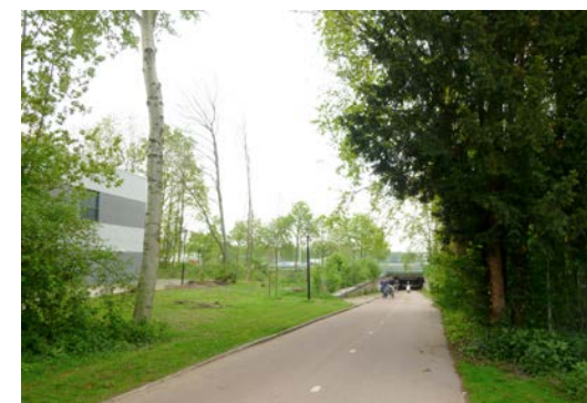
↑ Bestaande fietstunnel onder de A28 door, gezien vanaf het Uppsalapad.
