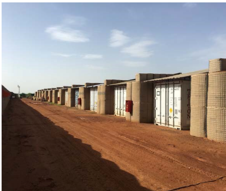
Bunkers met zonedak.
