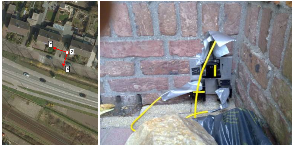
Figuur 11: Referentieband aan de Koningin Wilhelminastraat 5 (oost). Links: positie en richting van de versnellingsopnemers. Rechts: Versnellingsopnemers ter plekke van de fundering.
