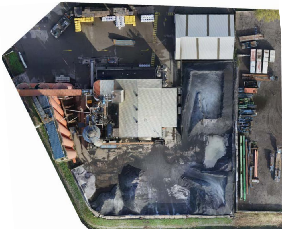
Afbeelding 1, luchtfoto locatie Eurogrit
