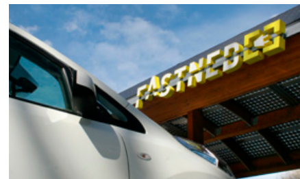
Fastned wil in totaal 230 snellaadstations langs de snelweg bouwen
