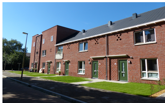
Afbeelding 1: Binnenhofjes fase 2 (Foto: Nijhuis Bouw)
