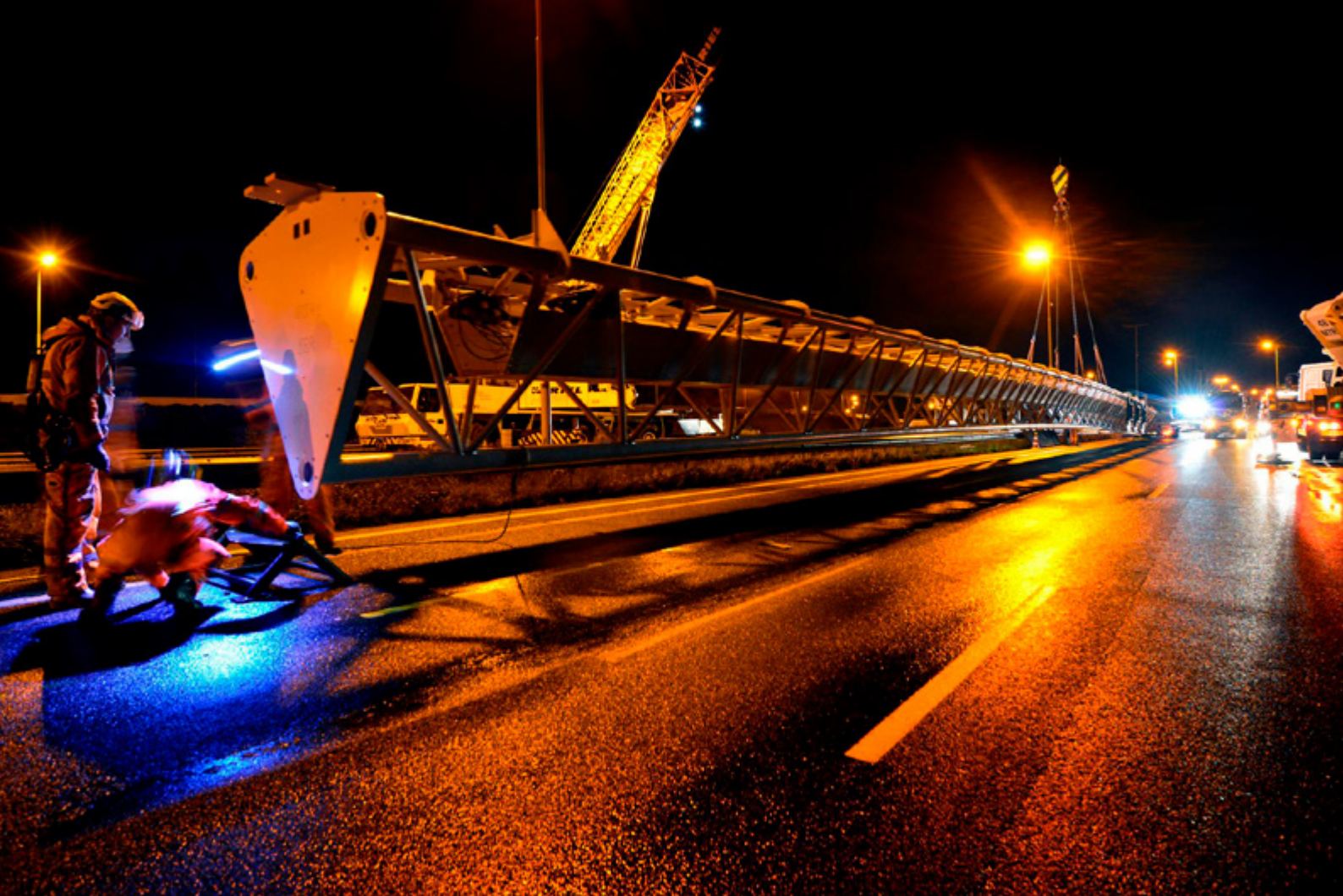
Ton Borsboom – Grootschalige onderhoudswerkzaamheden op de snelweg A27 bij Hilversum.
