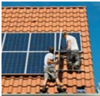
Op daken, gevels en ramen.
