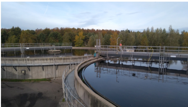
Afbeelding 2.3. Nabezinktanks van een RWZI (Bron: RIVM)
