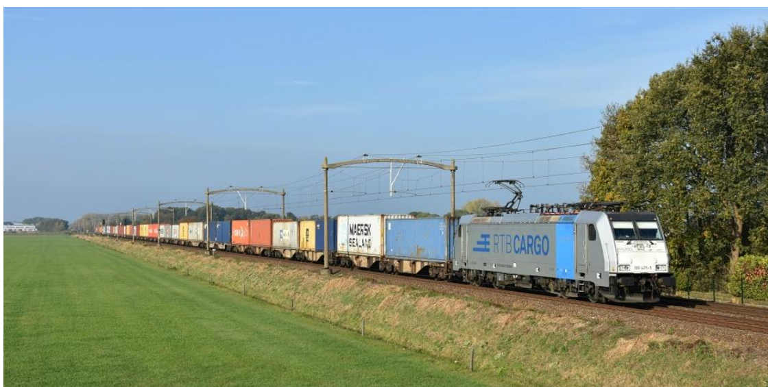
Afbeelding 9: Containertrein vanuit Rotterdam Maasvlakte over de Brabantroute via Breda. Na het gereedkomen van de Zuidwestboog bij Meteren zal de hoofdgoederenroute vanuit de Rotterdamse haven naar Venlo worden verlegd via de Betuweroute en Den Bosch.
