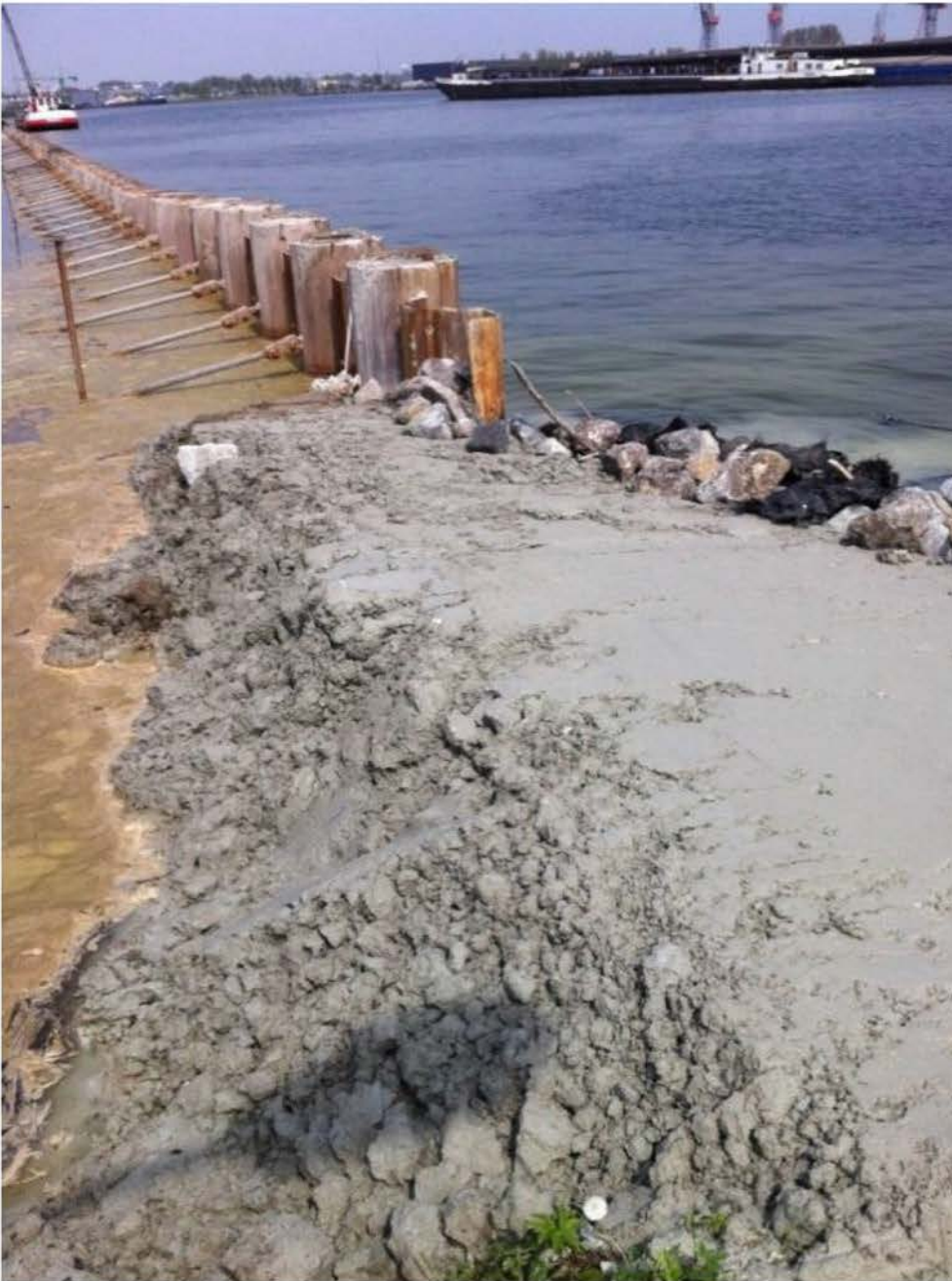
Figuur 4.3 Een tijdelijke dam van Noordse Leem (Noordzeekanaal Amsterdam)
