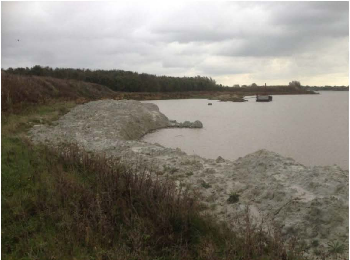
Figuur 2.4 Noordse Leem gebruikt voor afdichting van een zandwinput (Cuijk) – tijdens de aanleg
