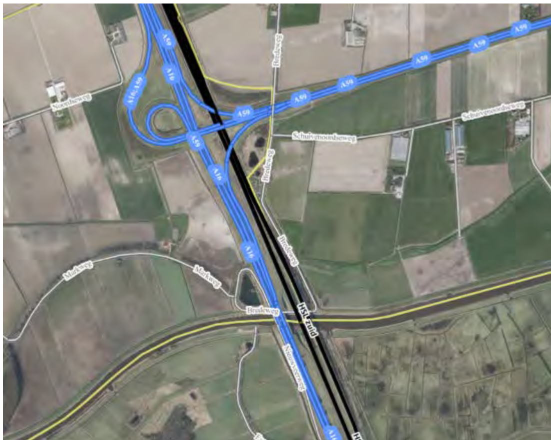
Figuur 21 Luchtfoto huidige situatie met de A16 en de HSL-Zuid naast elkaar over het riviertje De Mark.
