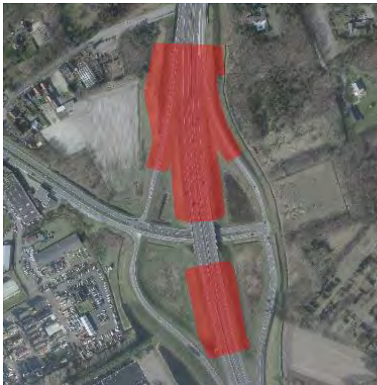
Figuur 4.8 Luchtfoto 2017 (bron: Globespotter), locatie 9.1: A4, aansluiting op de Randweg Oost / N286 in Bergen op Zoom. In rood de toepassing van TGG
