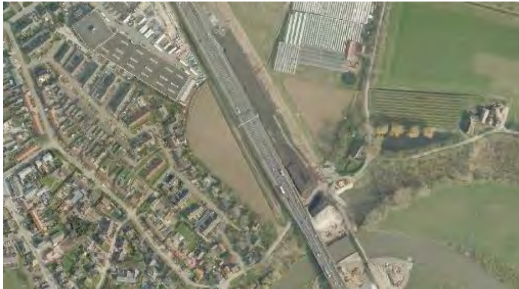
Figuur 4.7 Luchtfoto 2008 (bron: Globespotter), A2 aanleg brug over de Linge
