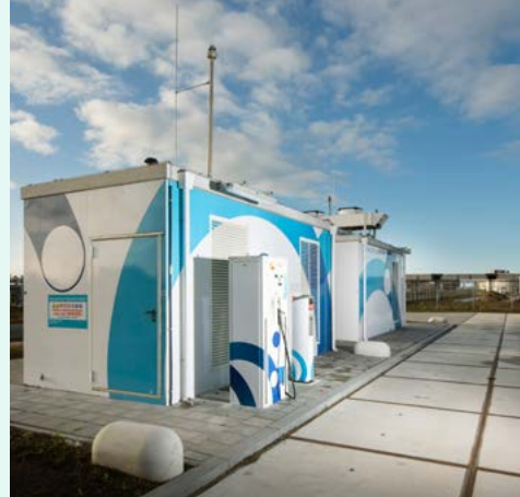
Waterstof-tankstation voor openbaar vervoer, Delfzijl.
