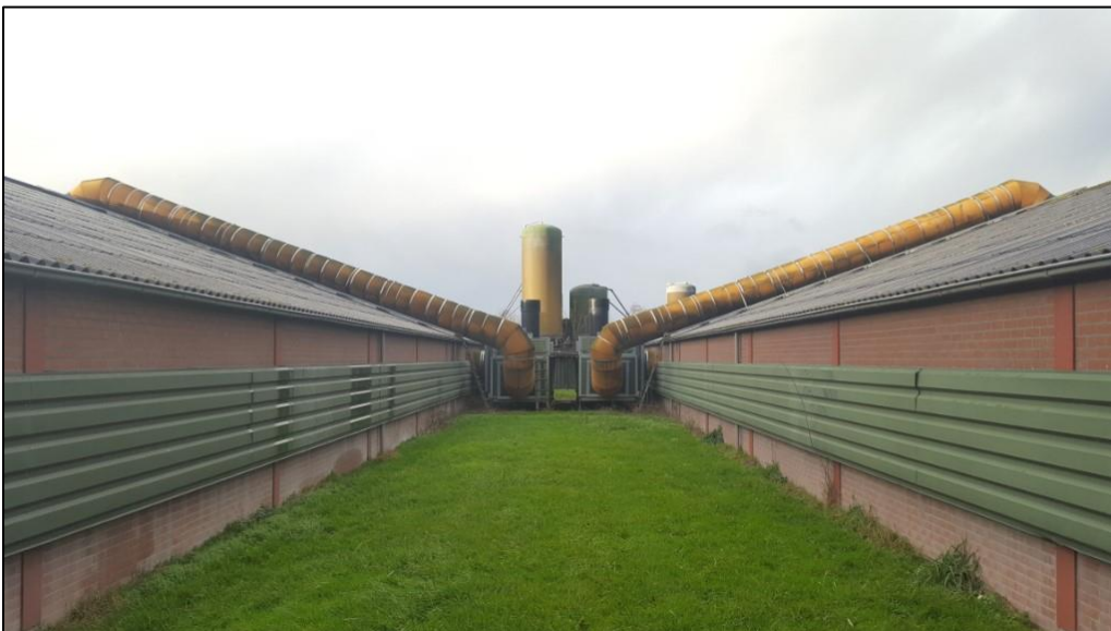
Ruimte tussen beide stallen met twee warmtewisselaars (foto genomen vanaf achterzijde)
