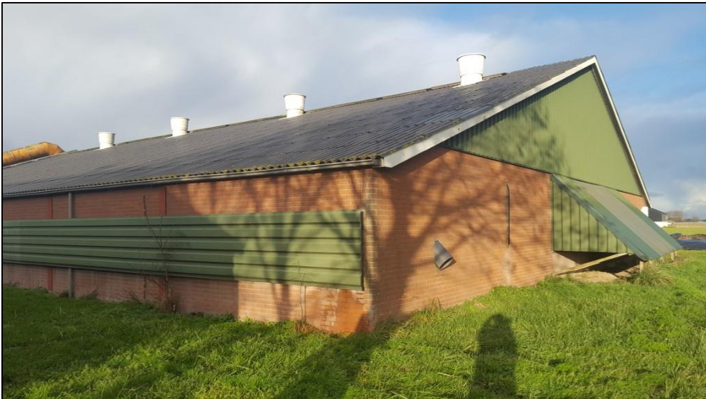
Westelijke zijgevel en achtergevel van stal 2 met kap over de drie eindgevelventilatoren
