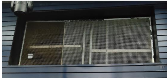
Figuur 10: Afzuigrooster in de zaal na schoonmaak en zonder plaat aan de rechter helft.
