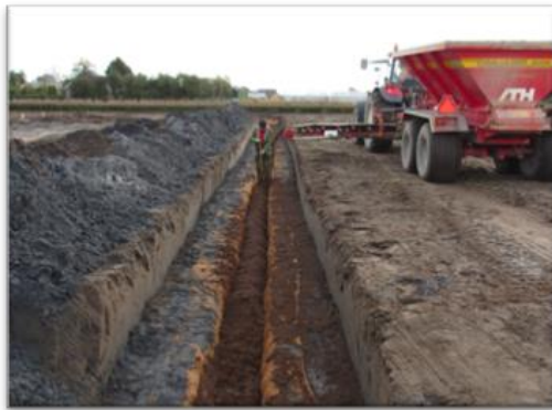
Figuur 9. Met ijzerzand omhulde drain
