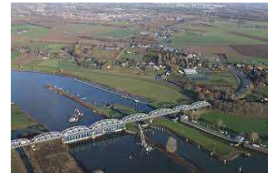
Figuur 10. Foto van het sluiscomplex in Grave
