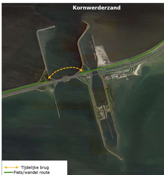
Figuur 22: Brug waddenzeezijde Kornwerderzand.
