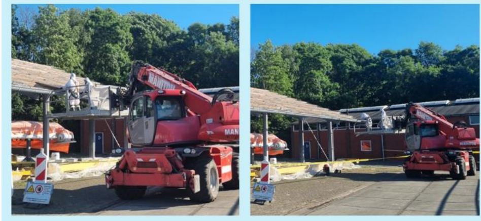
Figuur 3. Asbestverwijdering zonder schuim tijdens pilot
