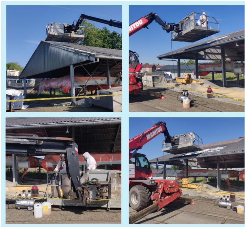
Figuur 4. Asbestverwijdering met schuim tijdens pilot
