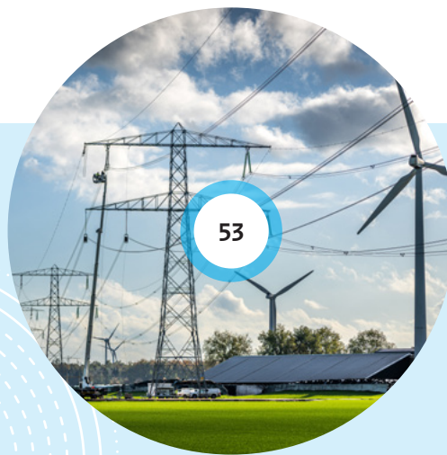
380 kV-hoogspanningsverbinding Diemen, Lelystad en Ens
