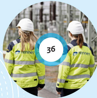
380 kV-hoogspanningsverbinding Rilland-Tilburg (Zuid-West 380 kV Oost)
