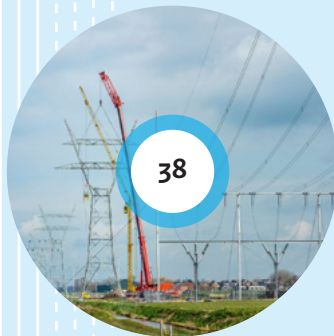
380 kV-hoogspanningsverbinding Geertruidenberg-Krimpen aan den IJssel/Crayestein
