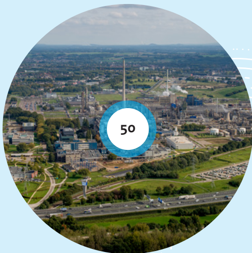
Netverzwaring Maasbracht-Graetheide naar 380 kV
