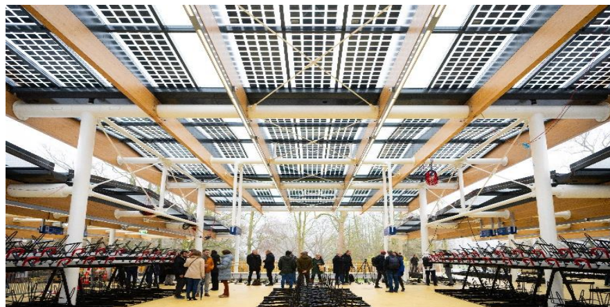
De nieuwe modulaire, duurzame en energieopwekkende fietsenstalling bij Station Dordrecht is eind 2024 geopend.
