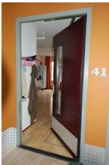
Brede deur met deurmotor
