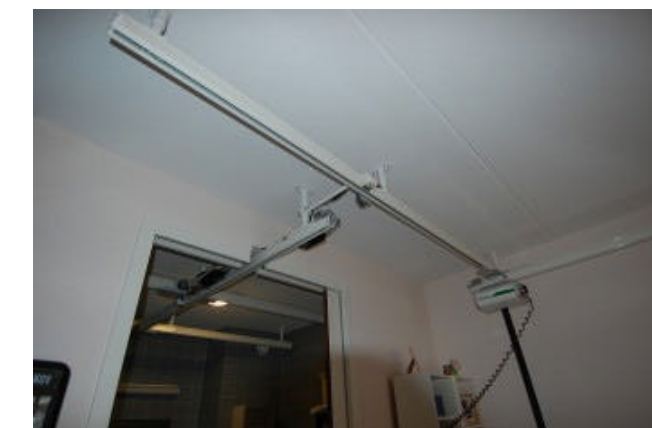
Plafondtilliftsysteem van slaapkamer naar badkamer
