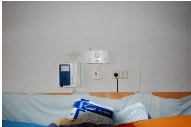
Videofoon, oproep/signalering op de slaapkamer
