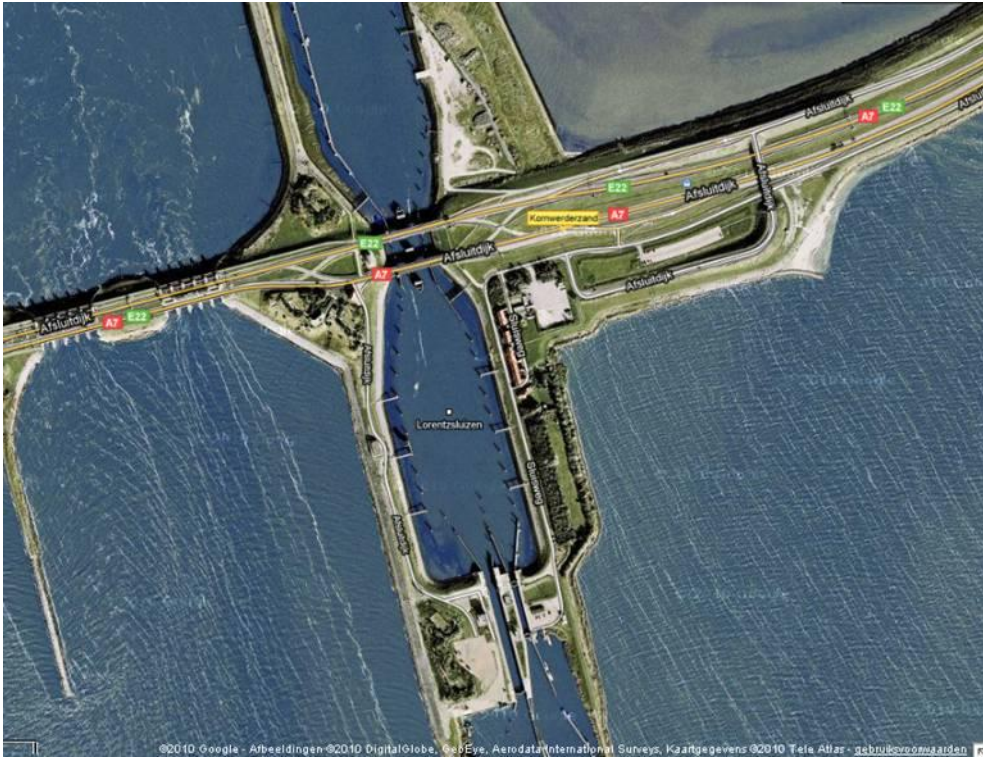
Figuur 2.3 Huidige situatie spuisluizen (10 stuks, links) en schutsluizen (2 stuks, midden-onder) Lorentzsluizen in Kornwerderzand
