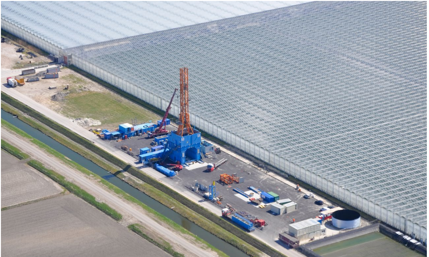
Geothermieboring gaande ten behoeve van de glastuinbouw (foto ECW Netwerk BV)
