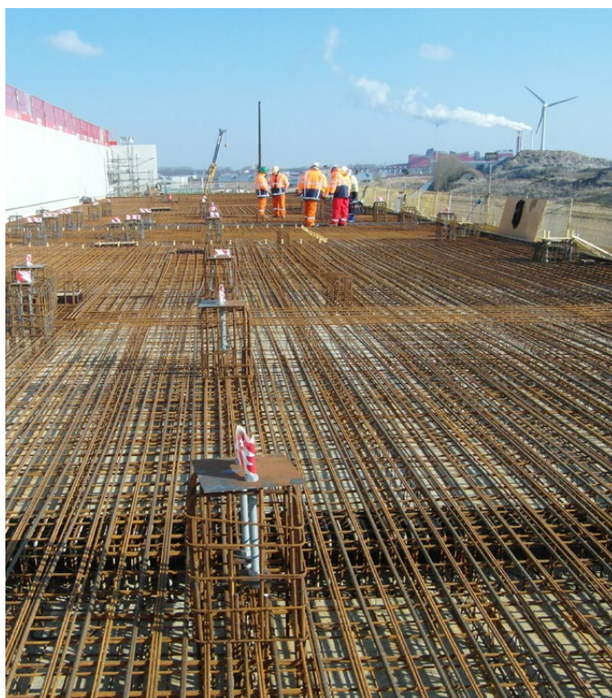
Gasopslag Bergermeer dak compressorgebouw (foto SodM)
