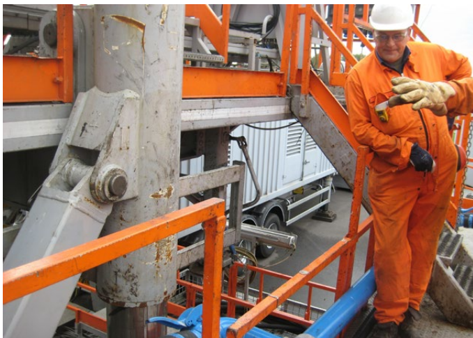
Inspecteur Nico Spijker op inspectie in Schoonebeek (foto SodM)
