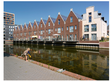
Nieuwbouw en Herstructurering
