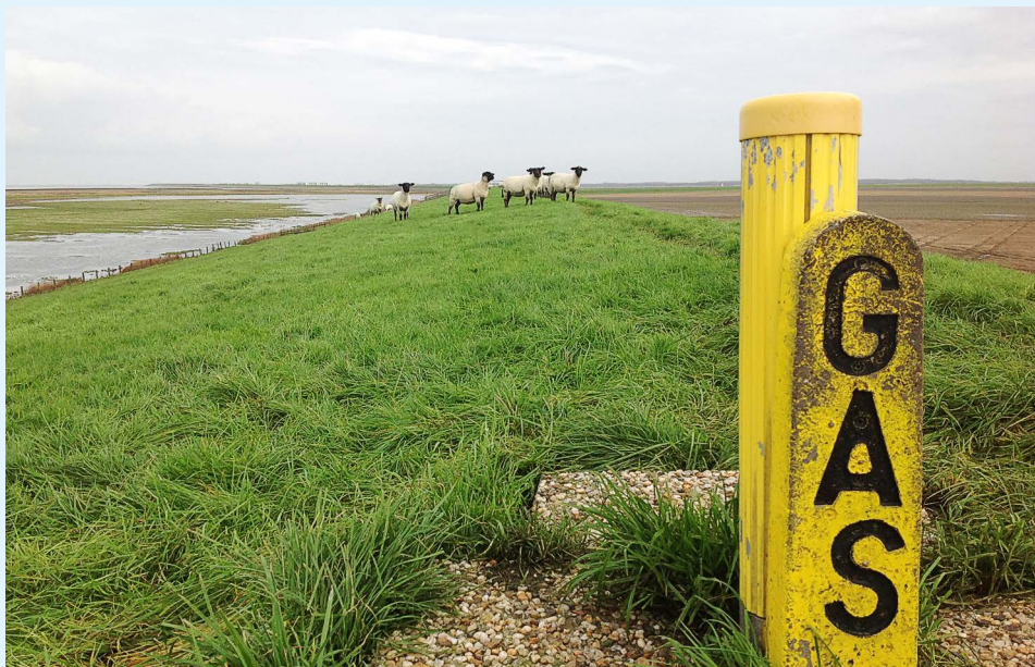
Aanduiding in het landschap dat er onder de grond een gasleiding loopt (foto SodM)
