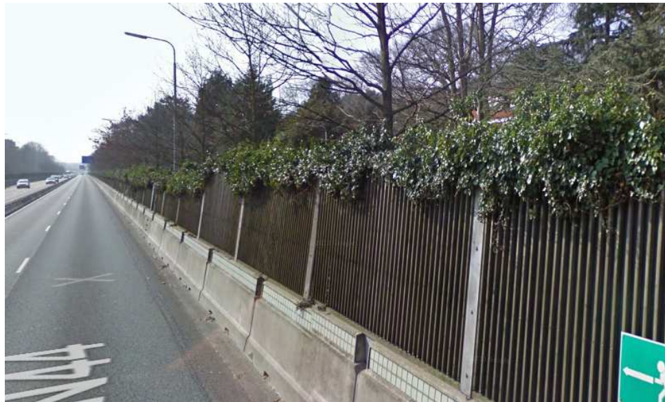
Figuur 10 Voorbeeld: Geluidscherm op barrier
