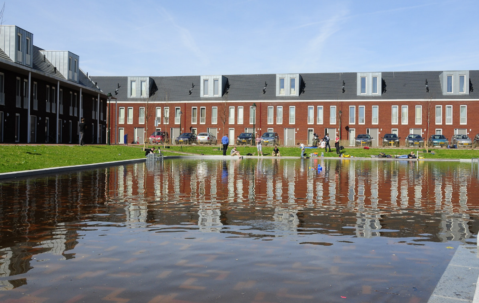
Figuur 6-b. Opgaven verbinden: waterberging en –vertier gaan samen op het Eikendonkplein in Den Bosch.
