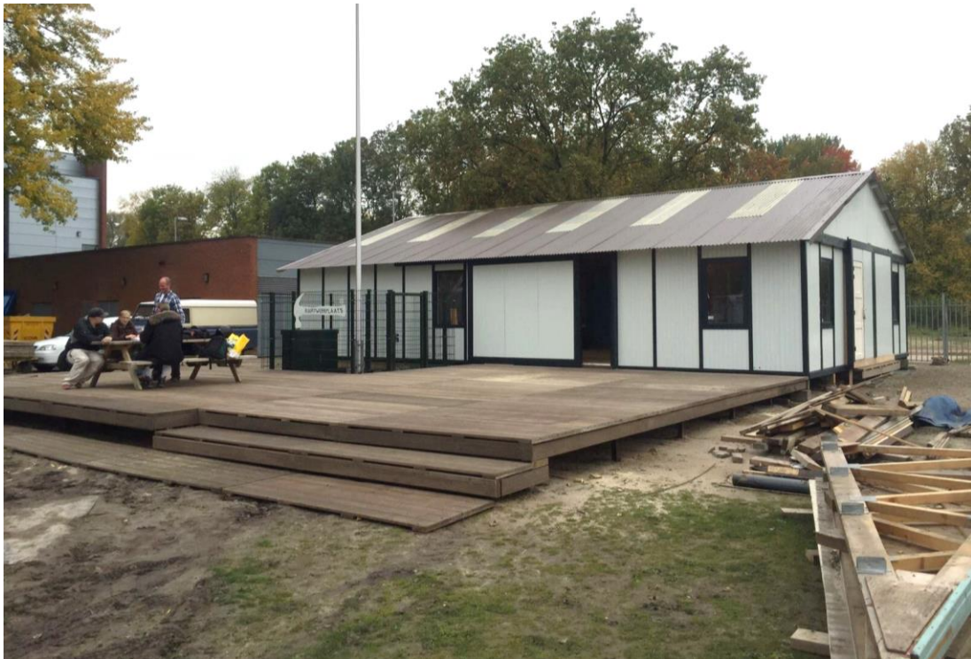
Het nieuwe paviljoen van Buurtwerkplaats Noorderhof in aanbouw.
