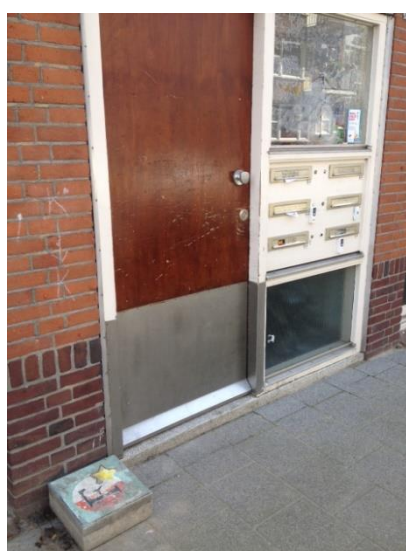
Foto 9 Er is onderhoud uitgevoerd aan de voordeur en brievenbussen in de Rotterdamse Mijnkintbuurt.
