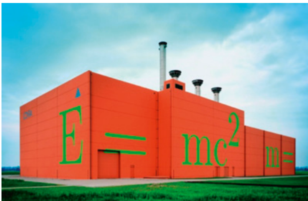
Figuur D.3 Het HABOG – de buitenkant.
