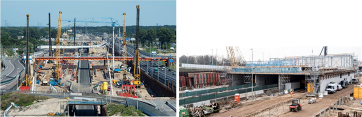
Figuur 11.3 Bouw tunnel A9 Gaasperdammerweg
