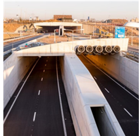
Figuur 9.1 Vier tunnelmonden
