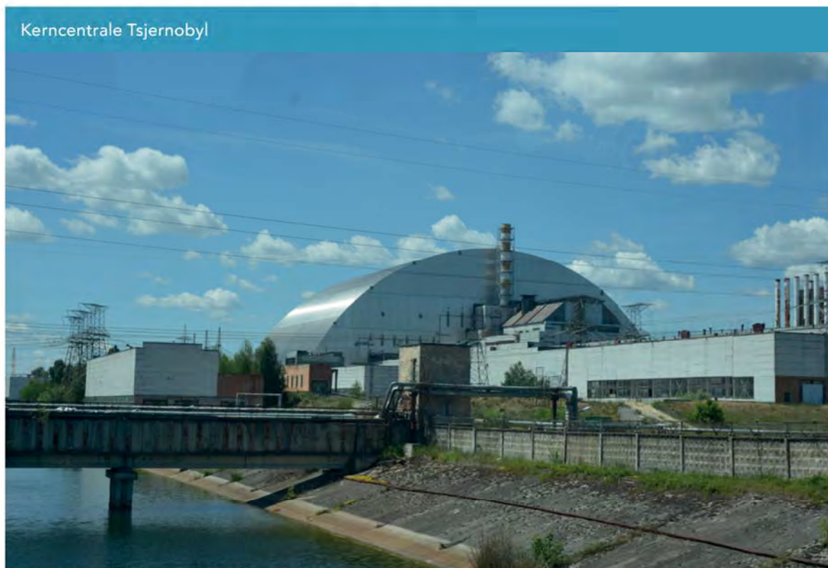
Figuur 3: Kerncentrale Tsjernobyl in 2017, waarbij de boogvormige overkapping is te zien die is geplaatst over de verwoeste reactor van de kerncentrale. (Bron: Onderzoeksraad voor Veiligheid)
