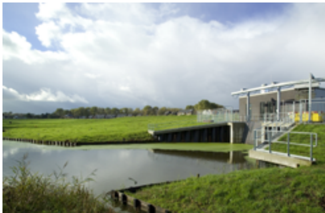
Het Rottegemaal handhaaft het gewenste waterpeil in de polder
