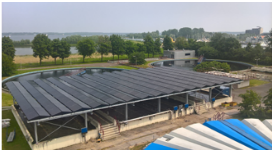
Zonnepanelen op de rioolwaterzuivering van Waterschap Amstel, Gooi en Vecht in Huizen
