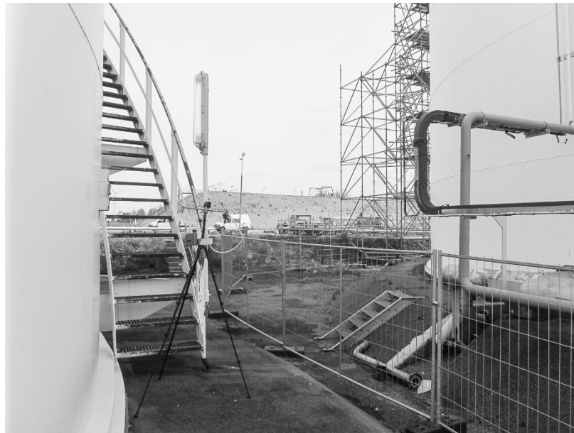
Meetlocatie 1C: Positie stationair meetpunt bij mangat (>5 m)
