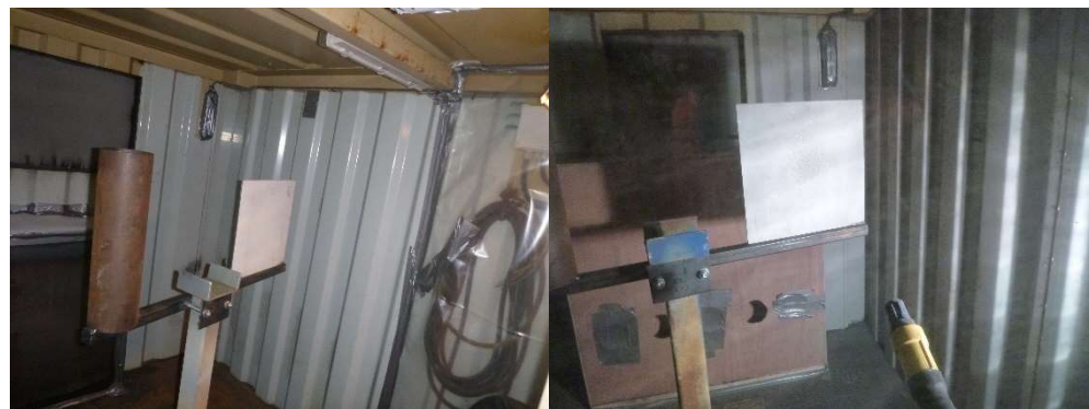
Figuur 6: Opstelling in straalcontainer, met de filterunit (links) en de constructie voor laten neerslaan van (grof) stof voor de filterunit (rechts).
