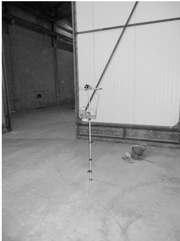
Meetlocatie 2A: Positie stationair meetpunt buiten de opening van de straalcabine
