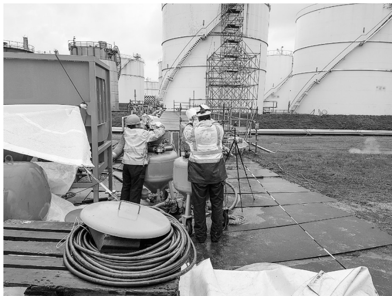
Meetlocatie 1C: Vullen van de straalketels met zakken, inclusief positie stationair meetpunt
