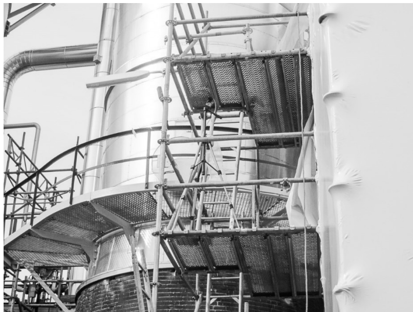
Meetlocatie 1B: Positie stationair meetpunt bij opening linkerkant straaltent
