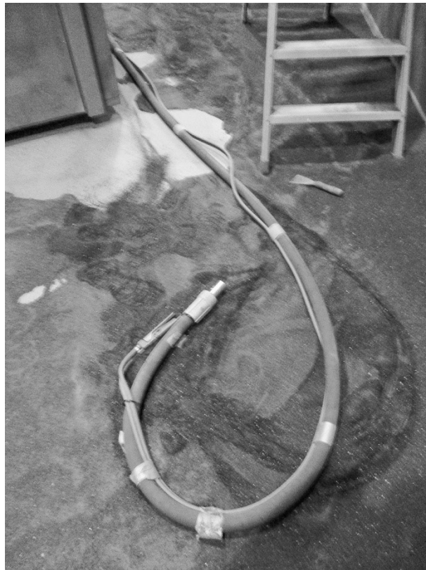
Meetlocatie 3: Straalapparatuur (inclusief straalnozzle) in straalcabine
