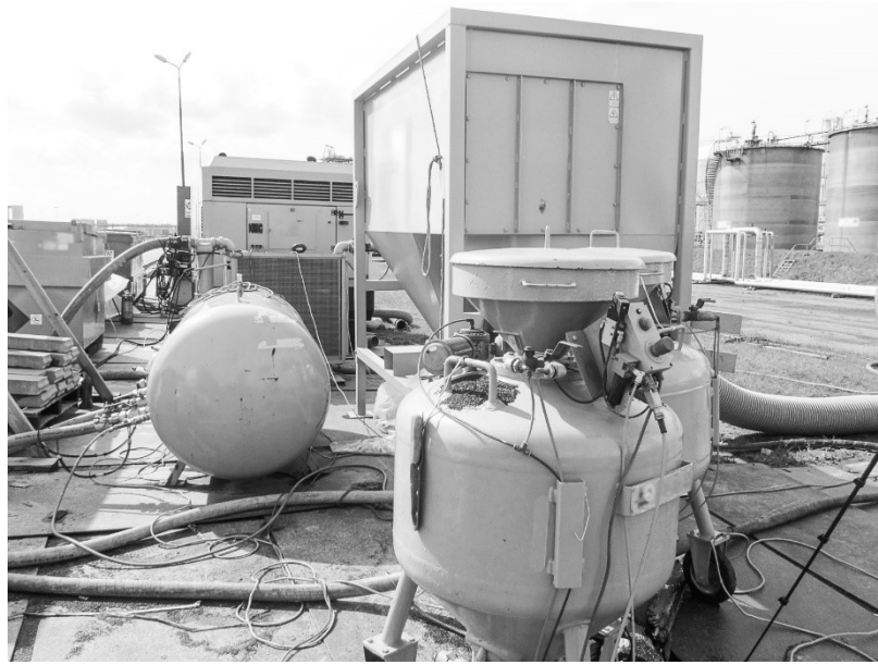
Meetlocatie 1C: Opstelling straalketels voor vulwerkzaamheden, met op de achtergrond onder andere de ventilatie-unit met klopperfilter en compressor voor toevoer straalgrit en toevoer verse lucht voor straalkap
