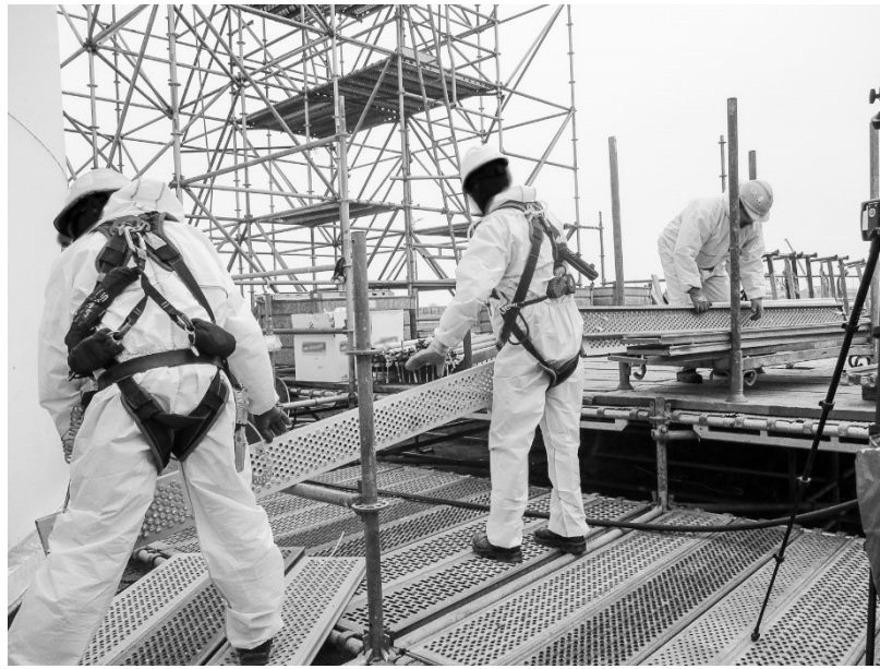
Meetlocatie 1C: Aannemen en opstapelen steigermateriaal, inclusief positie stationair meetpunt (vlakbij mangat)
