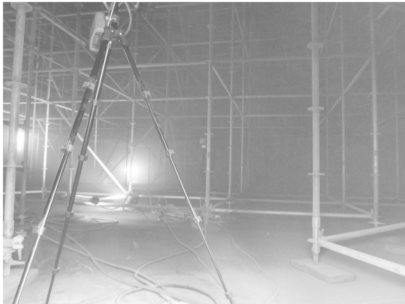
Meetlocatie 1C: Positie stationair meetpunt tijdens verplaatsen/inspectie
