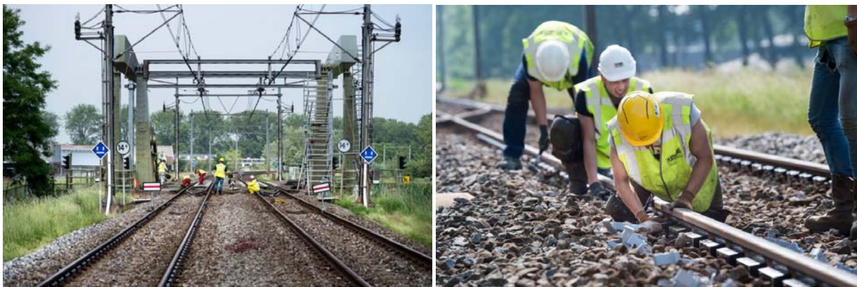
Afbeeldingen: aanleg raildempers in Purmerend
