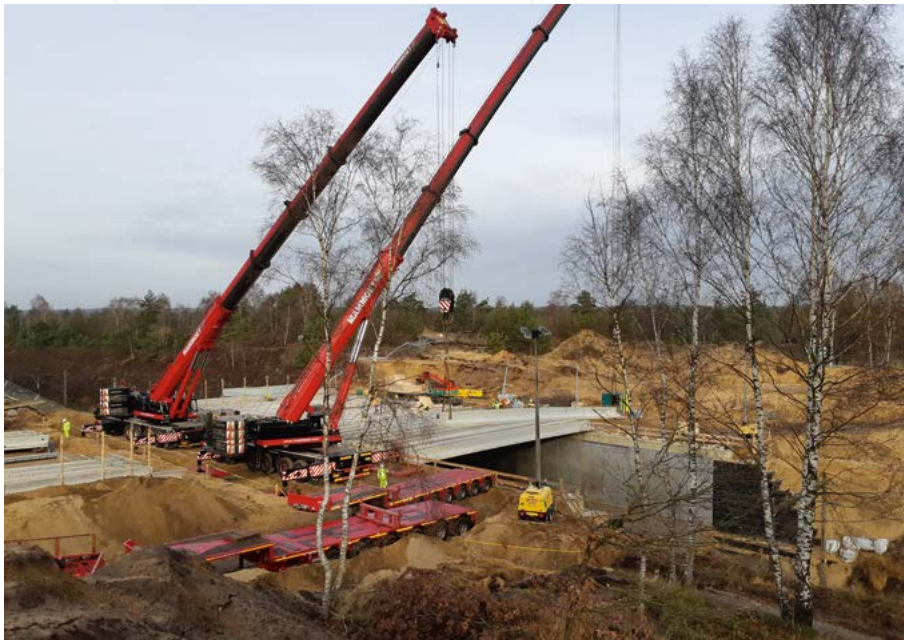
Plaatsen liggers bij natuurbrug Asselsche Heide.
