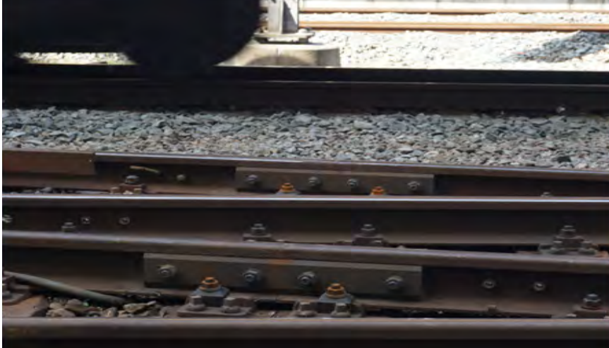
Afbeelding 10.1 ES-lassen in het spoor
