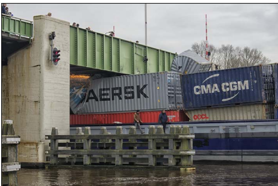
Aanvaring brug Burgumerdaam over het Prinses Margrietkanaal (foto A. de Boer)
