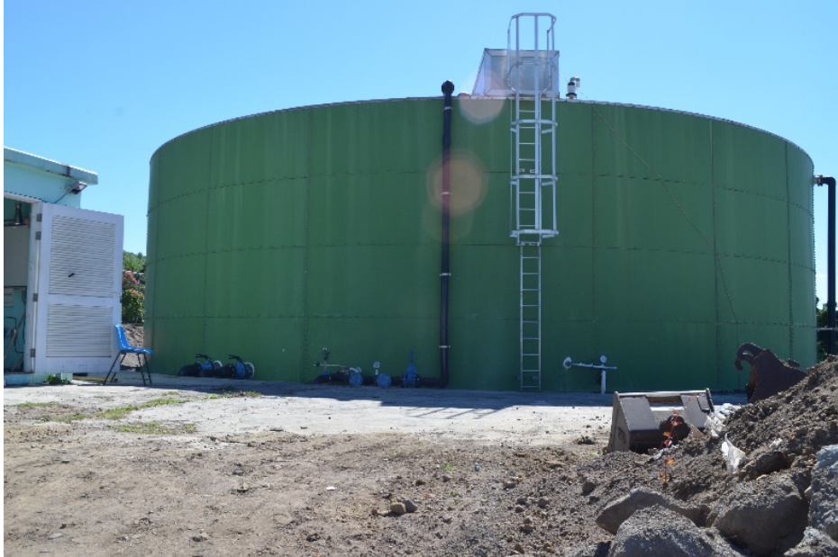
De oude wateropslagtank met een capaciteit van 1000 m 3
