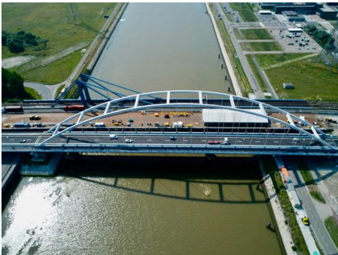
Figuur 9.3: Tent op de oude Suurhoffbrug die wordt gerenoveerd, de nieuwe boogbrug is sinds eind juni in gebruik
