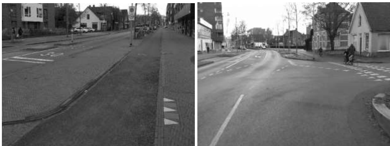
Afbeelding 35. Vrijliggende fietspaden langs 30 km/uur wegen in het centrum van Apeldoorn (Foto's: Paul Schepers)
