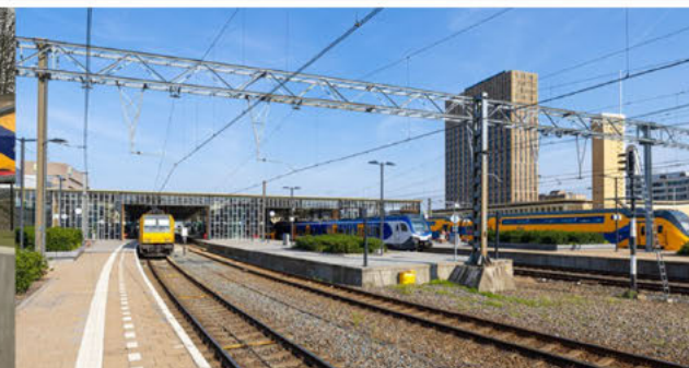
Spoorwerkzaamheden tussen Eindhoven Centraal en Weert
