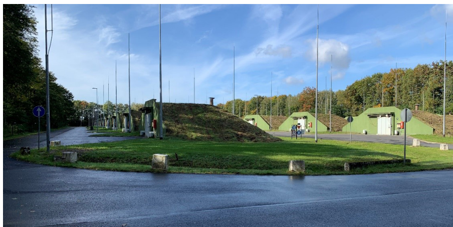
Afbeelding 1 Munitiebunkers voor opslag (bron: IVD).
