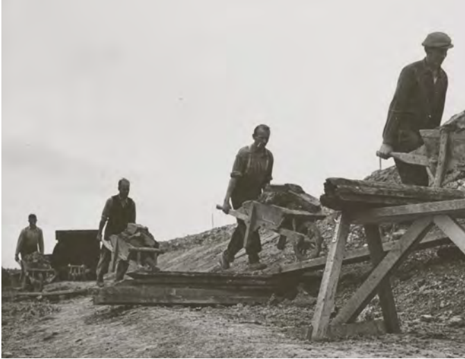
Amsterdamse Bos, aanleg 1934 (werkverschaffingsproject)
