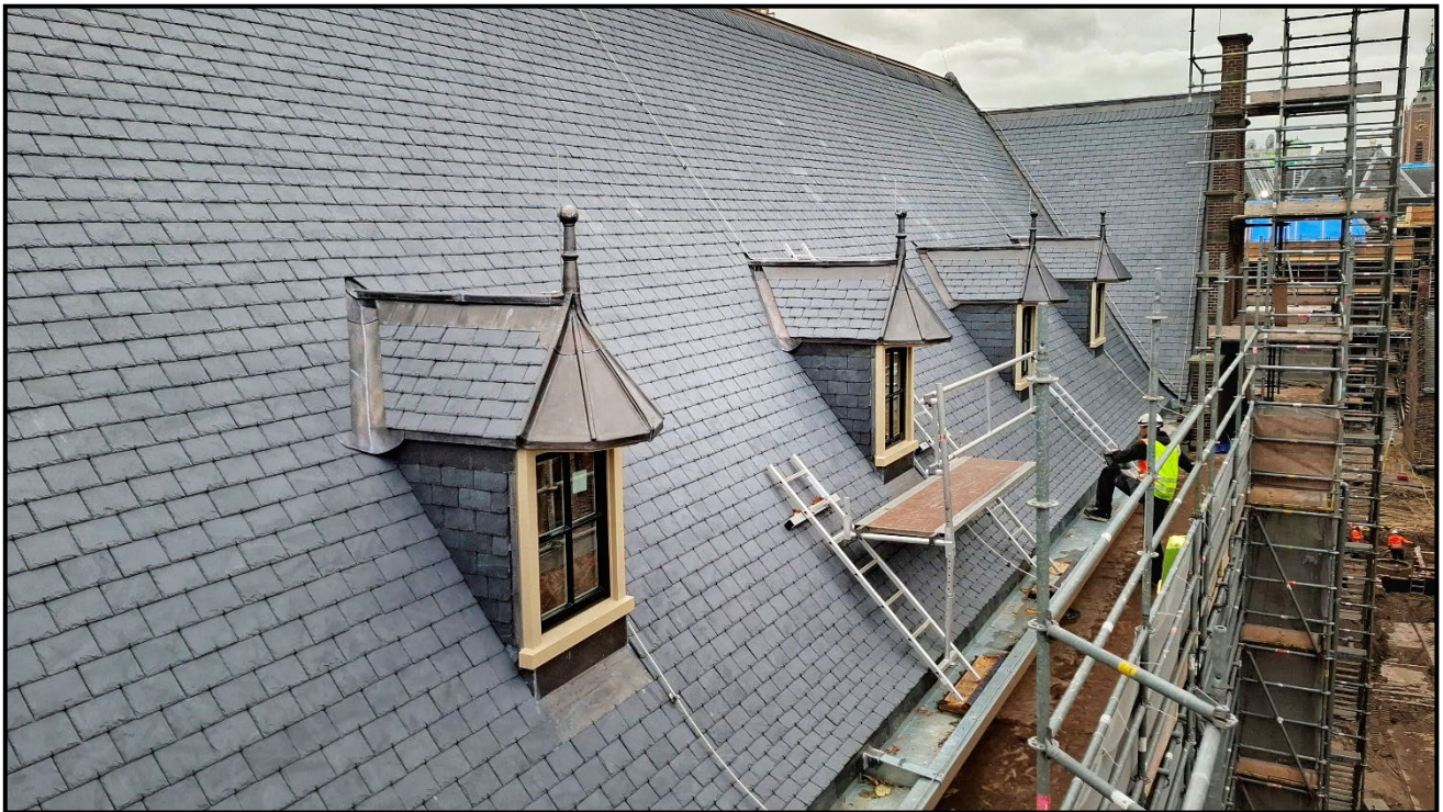
(Afbeelding 1: Het dak van gebouw C; na de isolatie worden de leien gelegd waarmee de daken zijn hersteld)
