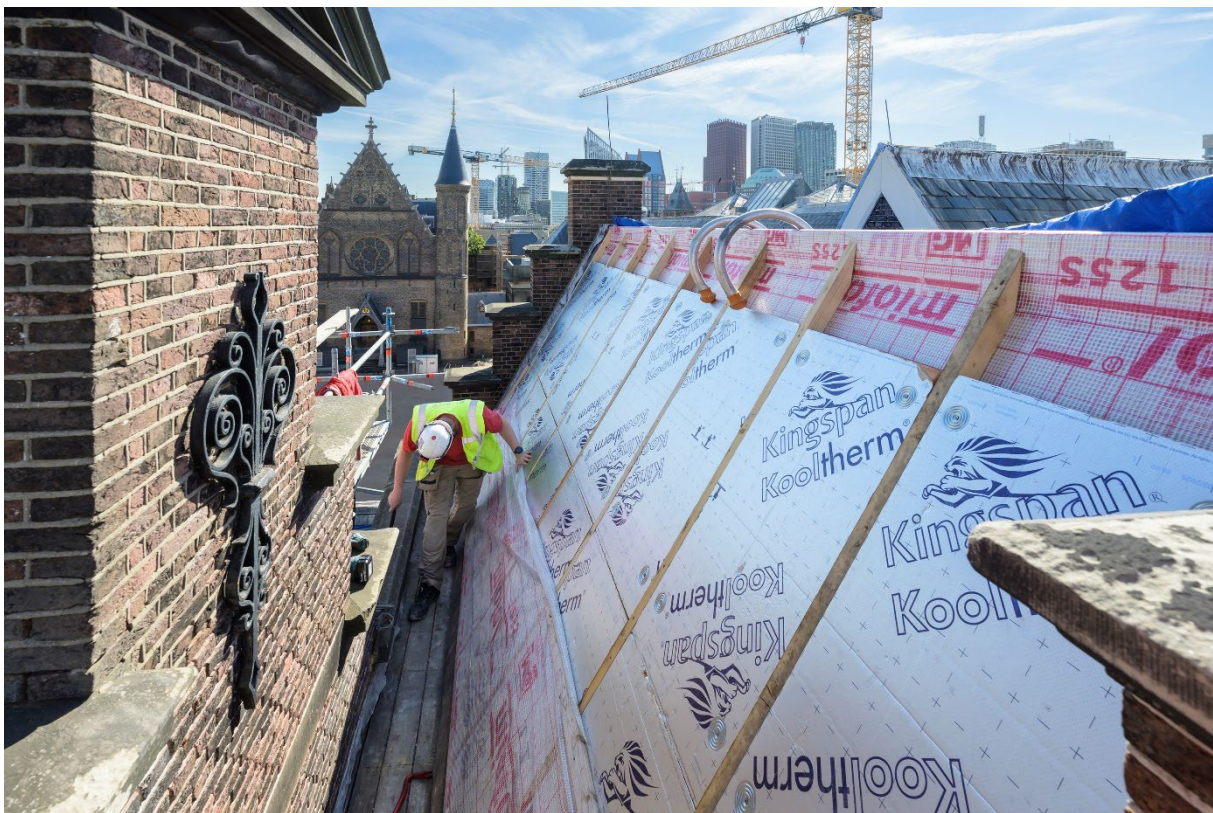
(Afbeelding 6: Renovatiewerkzaamheden Raad van State)
