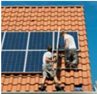
Op daken, gevels en ramen.
