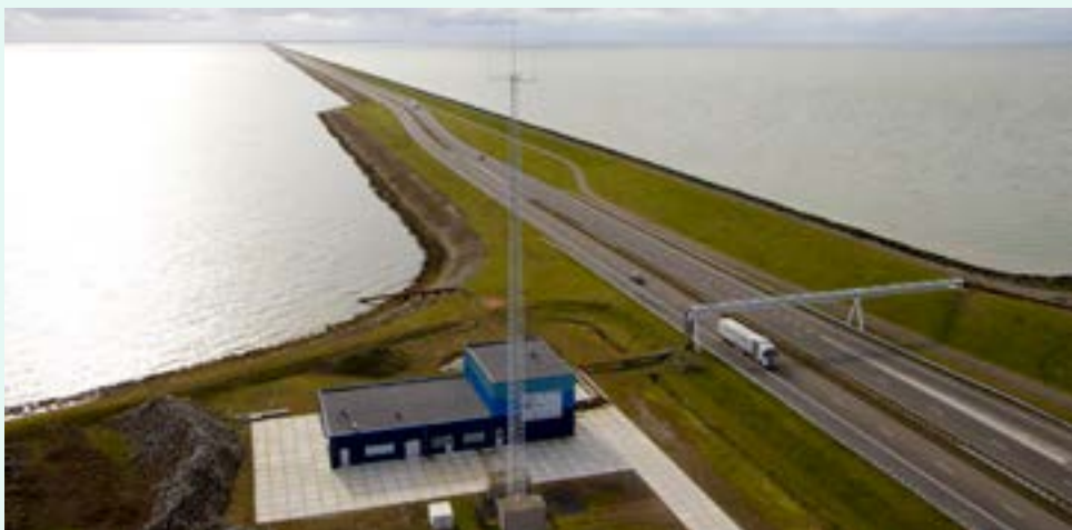
Thermische energie uit oppervlaktewater: Blue Energy op de Afsluitdijk. In deze proefinstallatie wordt energie gewonnen uit het verschil in zoutconcentratie van zout- en zoetwater.
