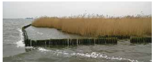
Hetzelfde eiland met een gesloten palenrij, februari 2016 (met doorgang voor zwemmende jongs en vis)
