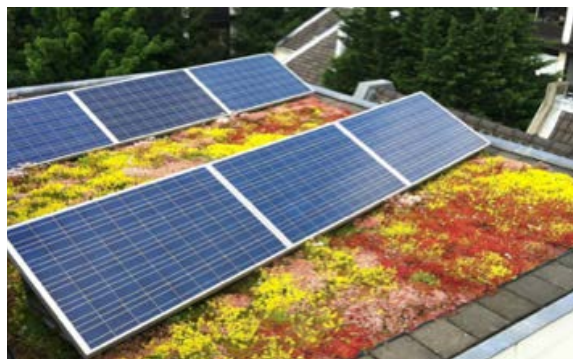
Foto 1 Adaptatie en mitigatie in één: Sedumdak met zonnepanelen. Locatie: Prinsengracht, Amsterdam. Fotografie door de Dakdokters.
